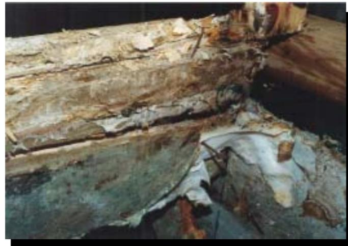
土台の腐朽と発達した菌糸
