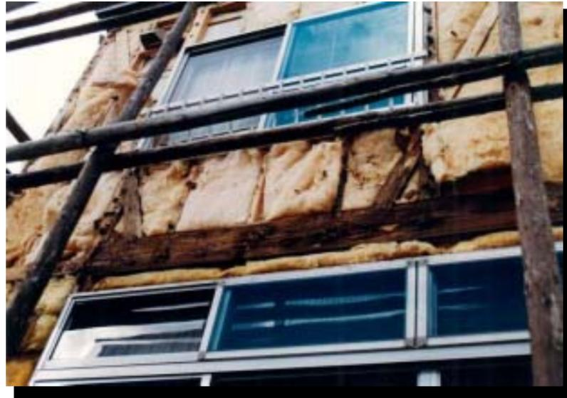
壁内結露による腐朽
