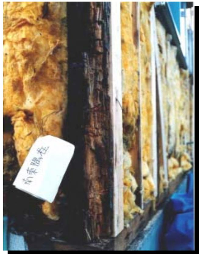
結露により腐食した柱
